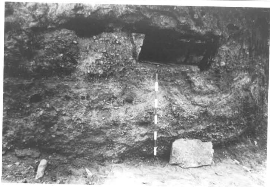
Làm.I.1, Vista general del Mas del Tancat (La Morera de Montsant, Priorat).
